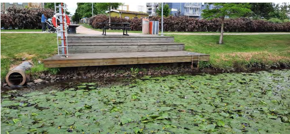
Figur 4 Erosionsskydd invid brygga på västra sidan Kvillebäcken, ungefär i höjd med Rundbäcksgatan.
