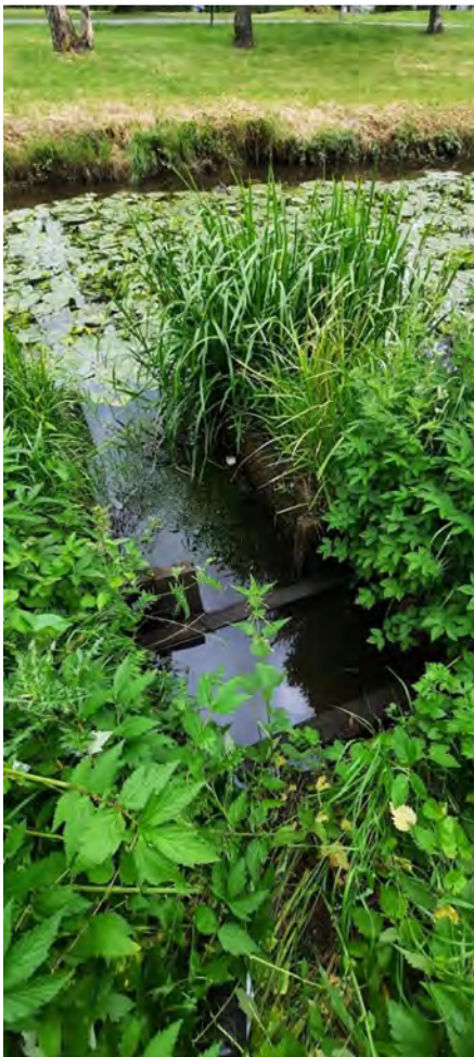
Figur 14 Befintlig träspont, troligen kring utlopp. Bäckens västra sida, ungefär mellan Borstbindaregatan och Långängen.
