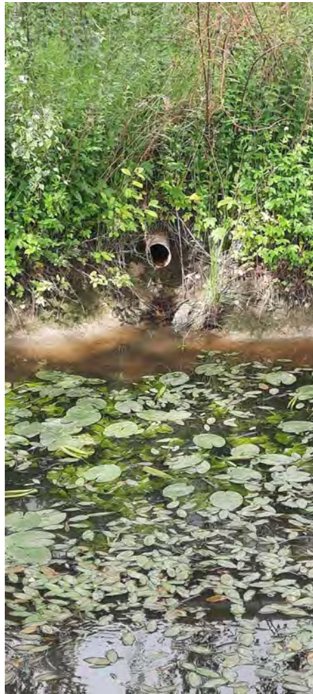
Figur 6 Mindre utlopp med tecken på erosion, västra sidan av bäcken.
