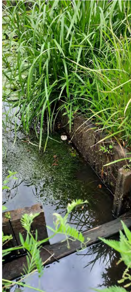
Figur 13 Befintlig träspont, troligen kring utlopp. Bäckens västra sida, ungefär mellan Borstbindaregatan och Långängen.
